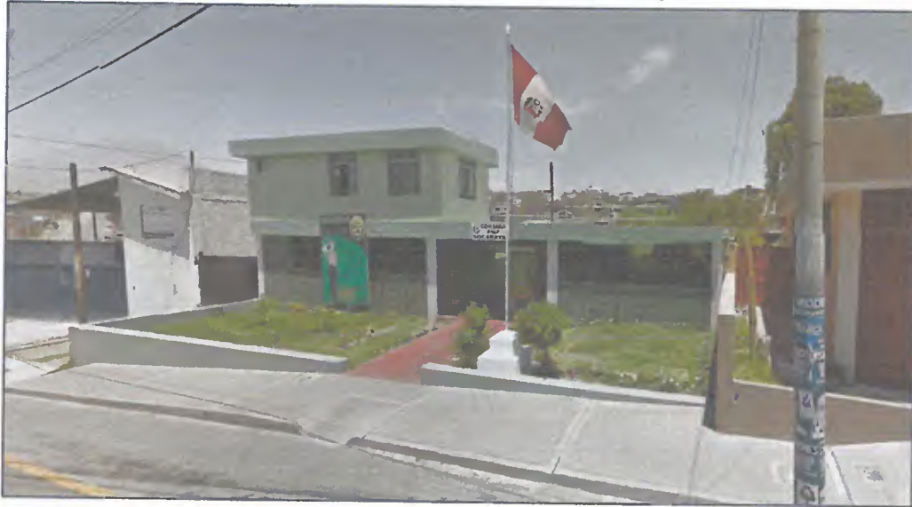
Fotografía N° 02: Comisaria sectorial PNP Socabaya
